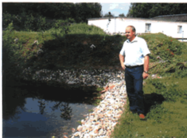
Jochen Smeets steht vor dem Auffangbecken, in dem das Regenwasser des gesamten Firmengeländes gesammelt wird
