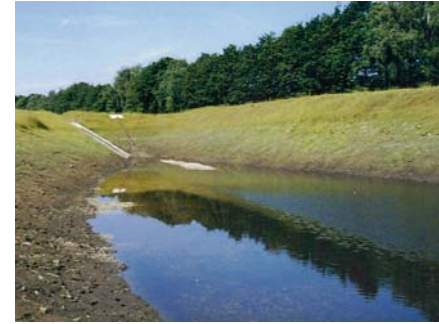
Abbildung 2: Erdbecken mit Speichervolumen von 3300 Kubikmeter Regenwasser zu Kühlzwecken, 1800 Kubikmeter Retentionsraum und 1200 Kubikmeter Volumenreserve zur zeitgleichen Nutzung zur Gebäudekühlung und Versickerung.
