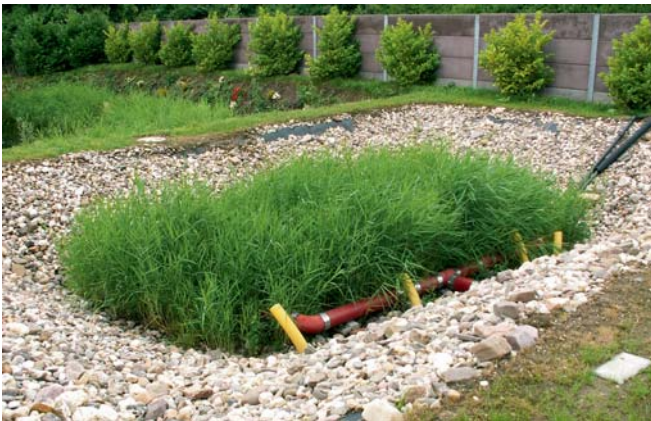
Abbildung 8: Vertikaldurchströmter Bodenfilter
